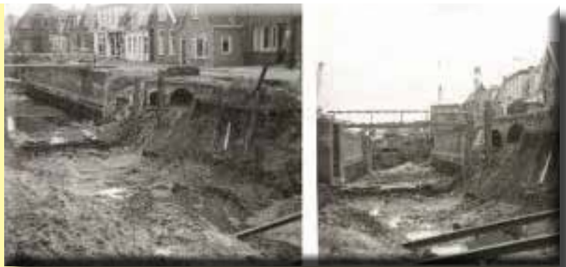
Afbeelding: Historische Kring Gemeente Leek • Beschrijving: Leek, dempen van het hoofddiep in het centrum. Eerst moet de watertunnel gebouwd worden. Hier zicht op De Dam en Kerkweg • Datum: 1959
